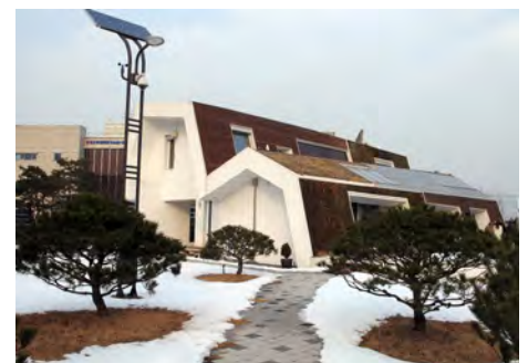
Green Home e'plus: Versuchshaus als Forschungsobjekt mit Dach- und Fassadenbegrünung.
